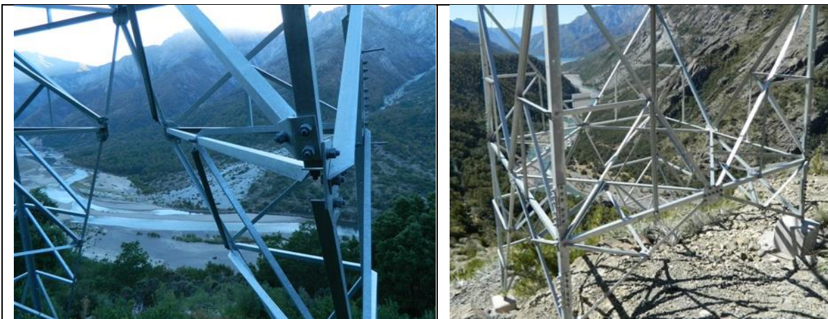
Figura 8. Inspección de posamiento en Estructuras: Revisión de las uniones metálicas horizontales ante posibles restos de evacuaciones cloacales de aves. (Estructuras 29, izq., y 42, derecha).
